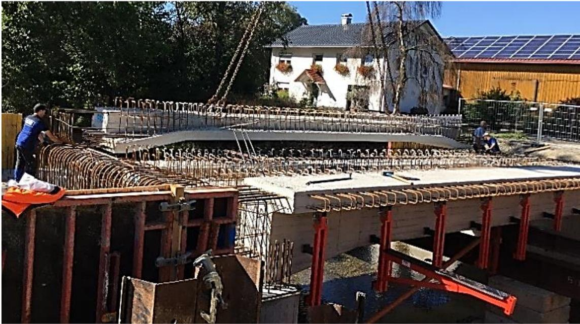
**Ortsmitte Günz** Am Dienstag, 26.09.2023 wurde mit dem Überbau der Günzbrücke in der Rummeltshauer Straße begonnen. Fertigteil für Fertigteil wurde in Millimeterarbeit eingesetzt.
