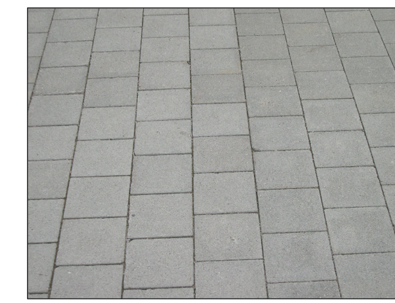
Gestaltungsbeispiel: Betonsteinpflaster, wasserdurchlässig
