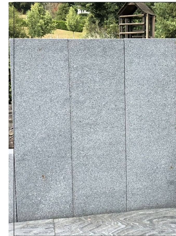
Gestaltungsbeispiel: Natursteinmauer, Granit Stelen
