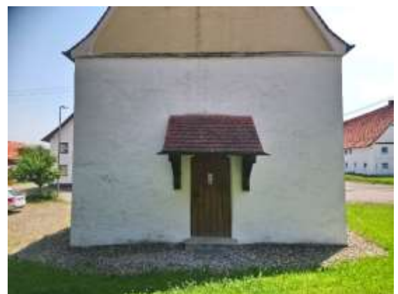
Blick nach Südosten: Giebel der Kapellen mit Eingang
