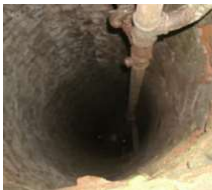
Blick in den Brunnenschacht
