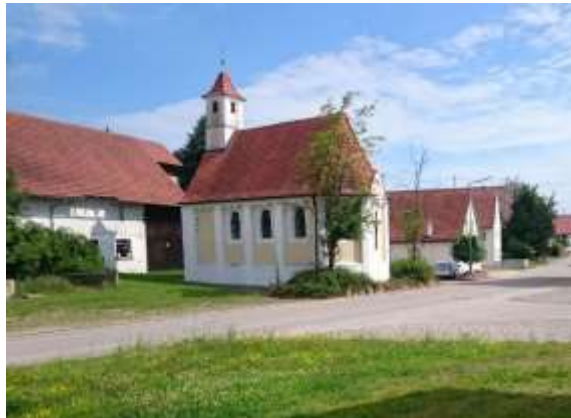
Blick nach Nordwesten: Kapelle St. Sebastian, dahinter das Schützenheim
