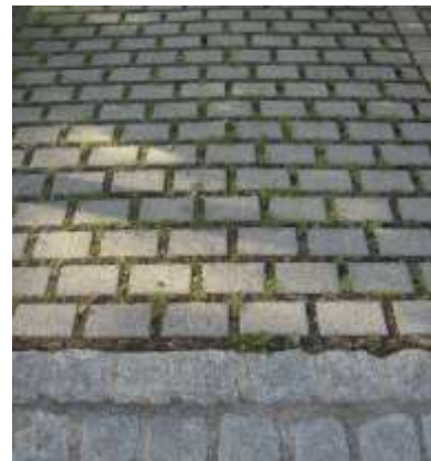
Gestaltungsbeispiel: Rasenfugenpflaster aus Betonstein
