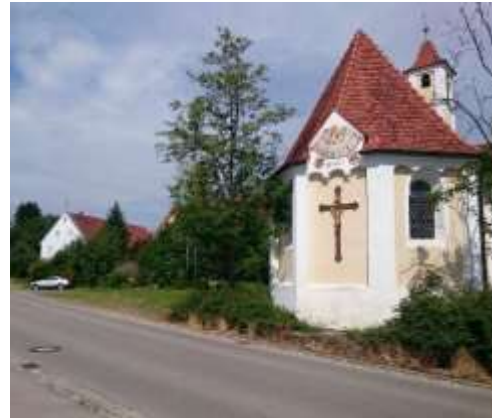
Blick nach Westen: Rückseite der Kapelle
