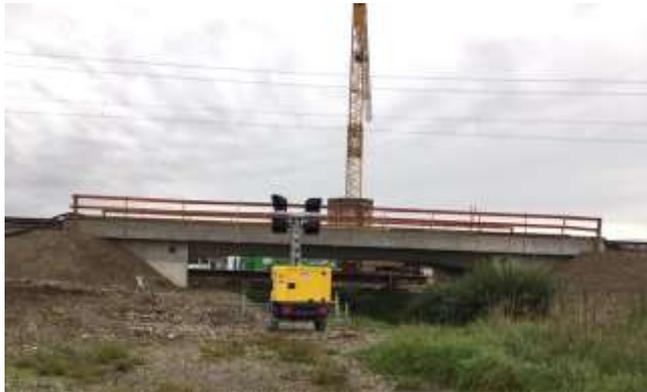
Die Bahnbrücke über die Schwelk wurde von Freitag- auf Samstagnacht eingeschoben. Die Bahnbrücke ist 400 t schwer, 160 m<sup>3</sup> Beton und 31 t Stahl wurden verbaut.
